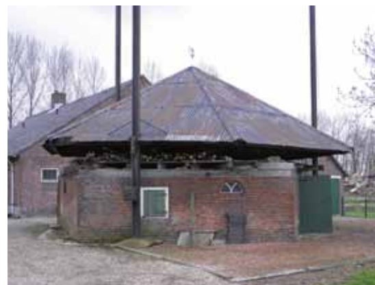
Hooiberg in Hei- en Boeicop. De oude schuurberg heeft een stenen onderbouw en is gerenoveerd met een ijzeren kap met drie roeden.
