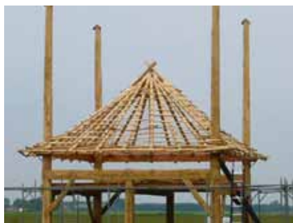
Wanneer het riet van de kap af is, is de constructie te zien (bron: www.skhn.nl ).
