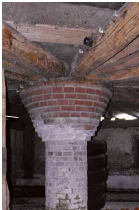
De stenen poer van een schuurberg. De balken van de zolder liggen op de poer en op de zijgevels.
