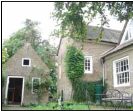
Oud-Alblas Noordzijde 7: huidige situatie. Prachtig gerestaureerd waarbij de kozijnen zijn vervangen en het metselwerk opnieuw werd opgetrokken. Alleen het bakhuis is ongewijzigd en is nu kippenhok.
