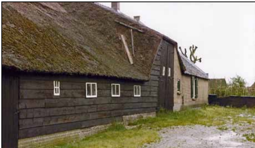
Oud-Alblas Noordzijde 7: westgevel voor de verbouwing in 1981.
