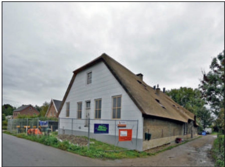
In Molenaarsgraaf is de restauratie van Graafdijk-Oost 16 nog in volle gang.
