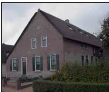
Het genomineerde pand in Hoogblokland.
