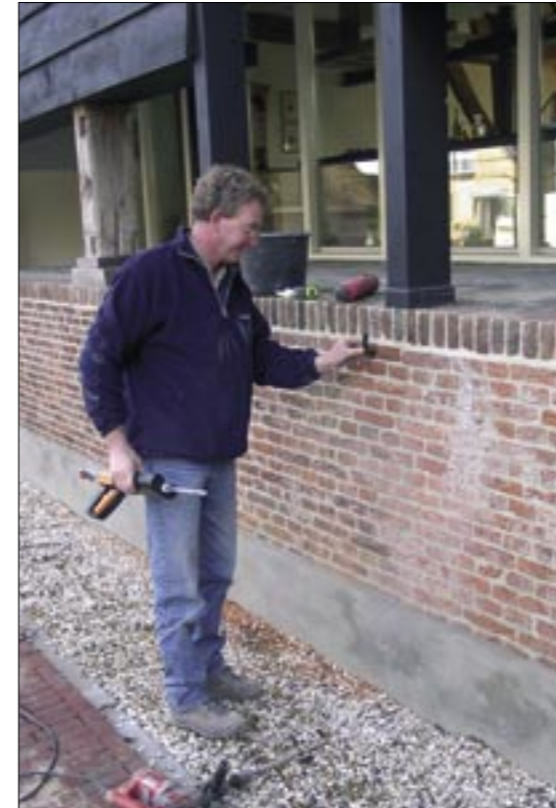
Wim Woudenbergh brengt één van de beugels aan voor de loopbrug onder de vloeddeur.
