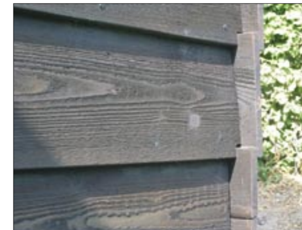
Geheel in stijl wordt in Ottoland gewerkt aan het behoud van de zwarte schuur. De hoek wordt a-symmetrisch uitgevoerd.
