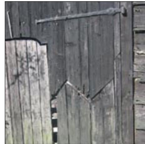
Een voorbeeld van de sobere aanpak. Regelmatig zijn de hooideuren aan-gescherfd en is alles in de creosoot gezet. Opvallend is dan toch nog het sierlijke detail in de bovenzijde van het loopdeurtje.
