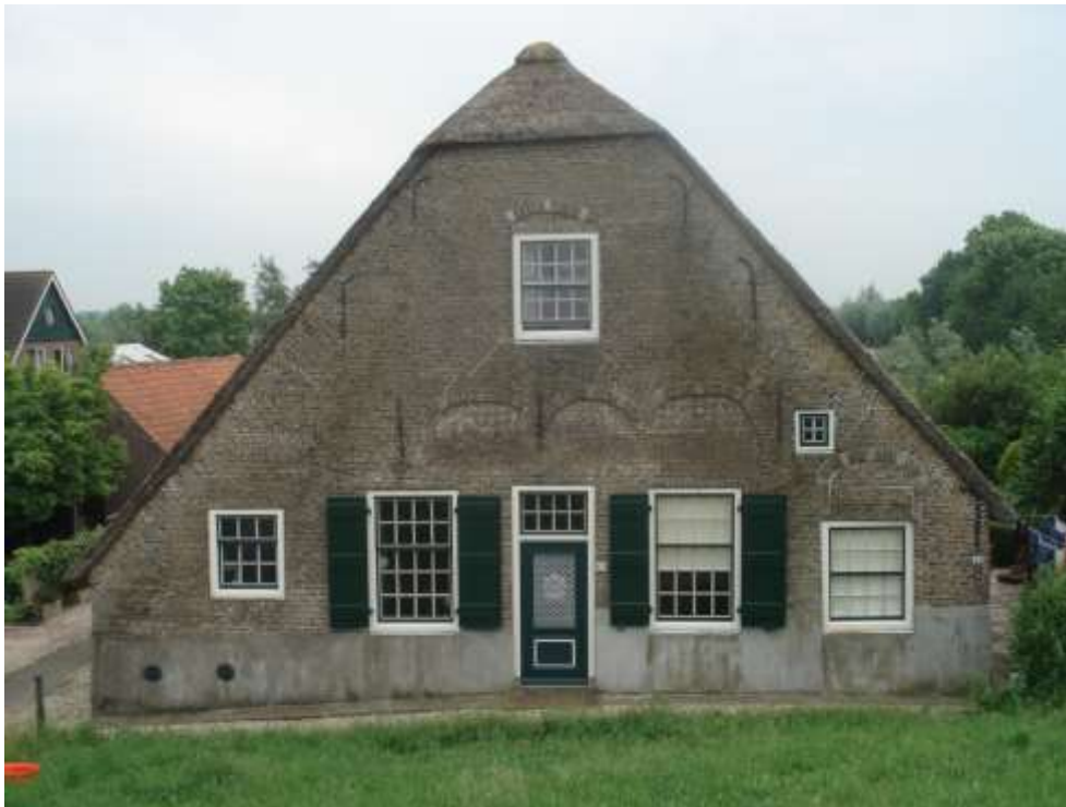
Boerderij langs de Lekdijk, met duidelijke sporen van de plaatsen waar oude ramen hebben gezeten.
