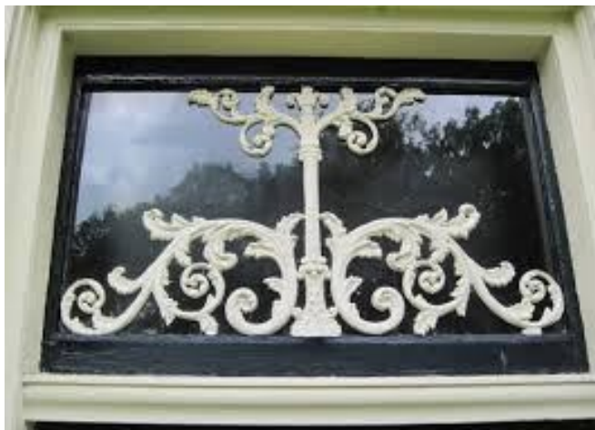
Een bovenlicht met levensboom
